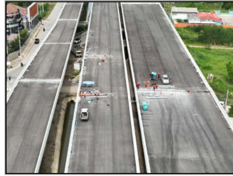
การเทคอนกรีตเชื่อมชิ้นส่วนโครงสร้างสะพาน (โครงการฯ ตอน 2)
