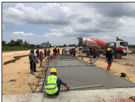
การเทพื้นคอนกรีตผิวจราจร (ด้านเก็บค่าผ่านทางนครปฐมฝั่งตะวันตก)
