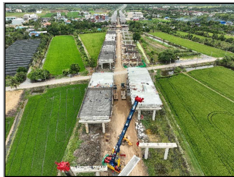
การติดตั้งชิ้นส่วนโครงสร้างสะพานข้าม ทางหลวงชนบท นบ.5014 (โครงการฯ ตอน 4)
