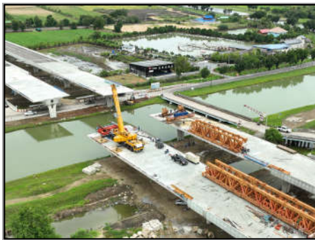
การติดตั้งชิ้นส่วนโครงสร้างสะพานข้าม คลองประปามหาสวัสดิ์ (โครงการฯ ตอน 3)
