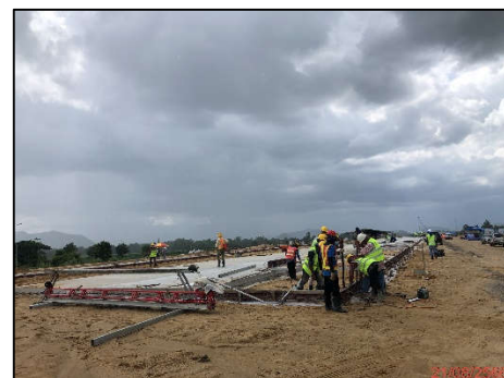
การเทพื้นคอนกรีตผิวจราจร (ด้านเก็บค่าผ่านทางกาญจนบุรี)
