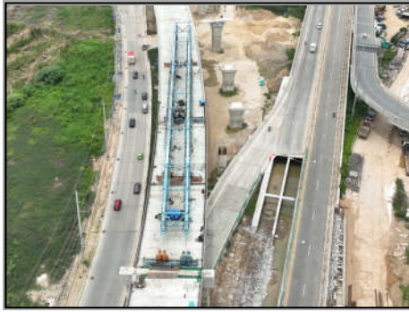
การติดตั้งชิ้นส่วนโครงสร้างสะพานต่างระดับบางใหญ่ (โครงการฯ ตอน 1)
