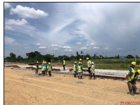
การเทพื้นคอนกรีตผิวจราจร (ด้านเก็บค่าผ่านทางท่ามะกา)
